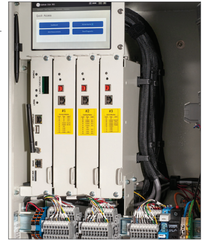
Ubicación de un máximo de 3 tarjetas complementarias
